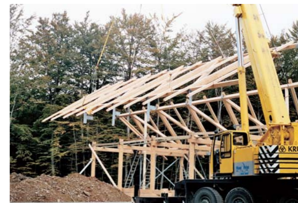
▲ ▼ Montage de la charpente triangulée «en arêtes de poisson».
