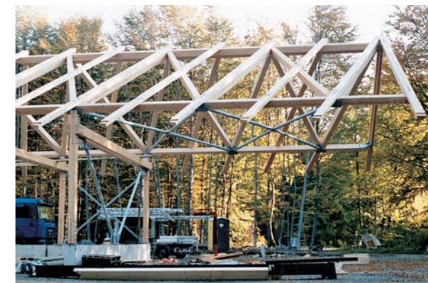
▲ ▼ Montage de la charpente triangulée «en arêtes de poisson».
