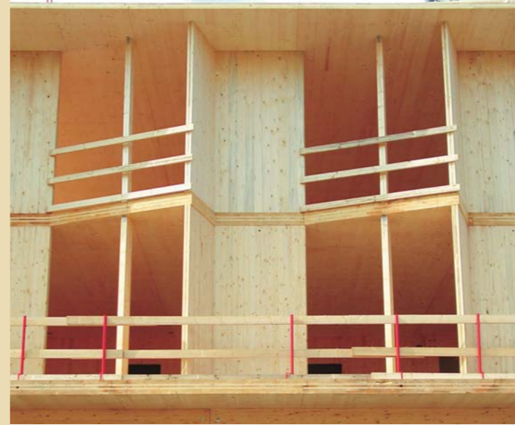
▲▼ Les façades et planchers sont constitués de panneaux porteurs KLH. La jonction de 2 panneaux sur l'angle donne de l'épaisseur à la façade.
